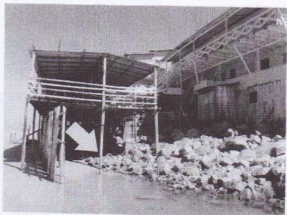
FOTO 29- DETALHE PARA AS ROCHAS COLOCADAS NA PRAIA
