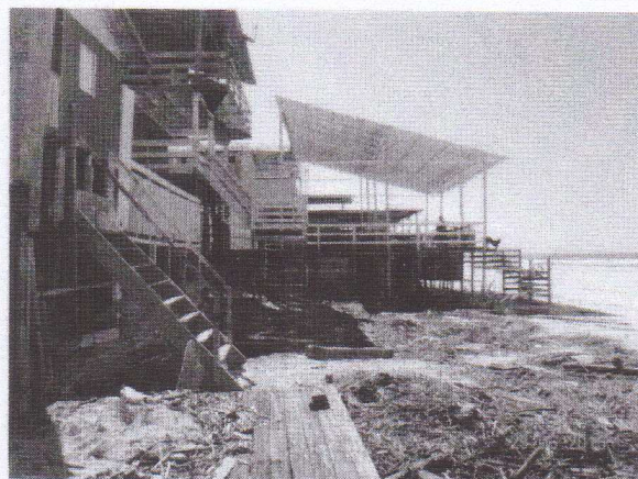
FOTO 22- VISTA GERAL DAS EDIFICAÇÕES DE MADEIRA LOCALIZADAS EM ÁREA CONSIDERADAS DE RISCO
