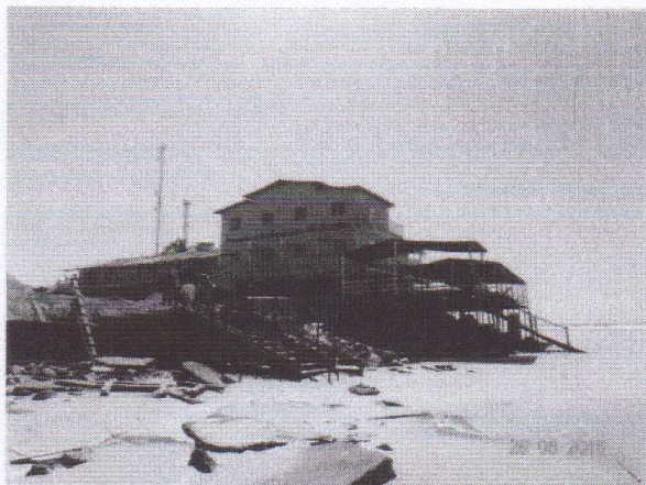
FOTO 25- EDIFICAÇÕES EM CONCRETO ARMADO LOCALIZADAS EM ÁREA DE DUNAS
