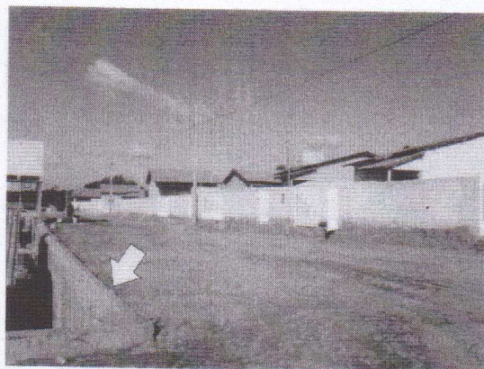
FOTO 02- VISTA GERAL DO CONDOMÍNIO DETALHE PARA O NÍVEL DA RUA E DAS CASAS; E PARA O PERIGO DO DESNÍVEL (SEM PROTEÇÃO)
