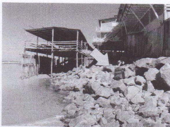
FOTO 27- DETALHE PARA AS ROCHAS COLOCADAS NA PRAIA
