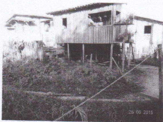
FOTO10- DETALHE PARA AS CONSTRUÇÕES DE MADEIRA
