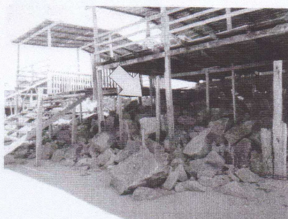
FOTO 30- DETALHE PARA AS ROCHAS COLOCADAS NA PRAIA
