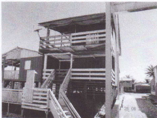
FOTO 19- VISTA GERAL DAS EDIFICAÇÕES DE MADEIRA LOCALIZADAS EM ÁREA DE DUNAS
