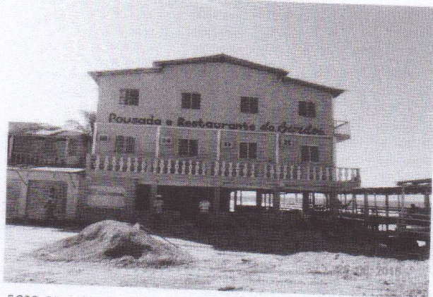
FOTO 01- VISTA GERAL DAS EDIFICAÇÕES DE CONCRETO ARMADO
