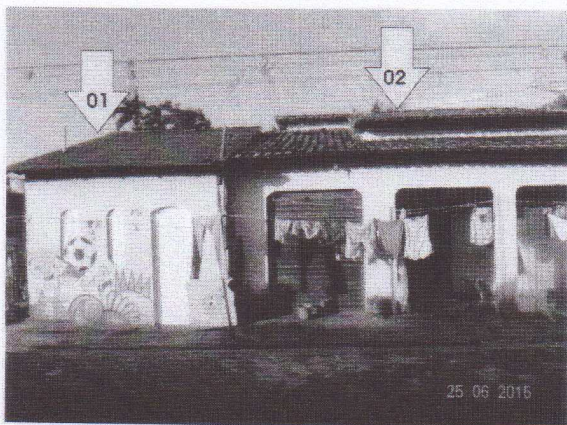
FOTO 01- VISTA GERAL DA CASA 104 (CASA 01 E 02)
