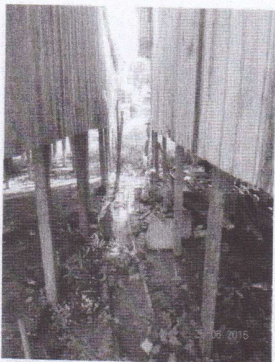
FOTO11- DETALHE PARA AS CONSTRUÇÕES DE MADEIRA
