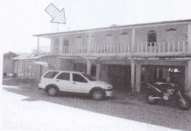
FOTO 04- VISTA GERAL DAS EDIFICAÇÕES DE CONCRETO ARMADO DETALHE PARA O PRÉDIO "VERDE"
