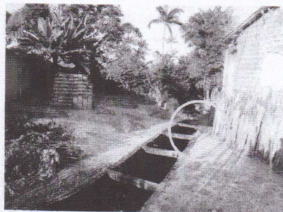
FOTO 04- DETALHE PARA A DISTÂNCIA DA GALERIA DE DRENAGEM E A CASA 01
