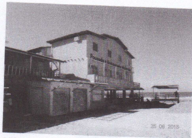
FOTO 02- VISTA GERAL DAS EDIFICAÇÕES DE CONCRETO ARMADO
