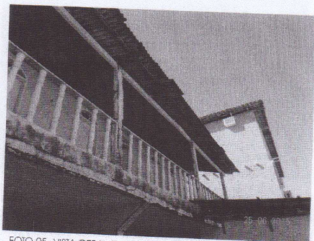
FOTO 05- VISTA GERAL DAS EDIFICAÇÕES DE CONCRETO ARMADO DETALHE PARA O PRÉDIO "VERDE"
