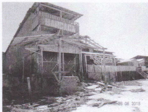
FOTO 20- VISTA GERAL DAS EDIFICAÇÕES DE MADEIRA LOCALIZADAS EM ÁREA DE DUNAS
