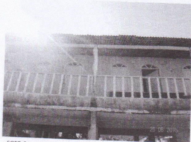
FOTO 06- VISTA GERAL DAS EDIFICAÇÕES DE CONCRETO ARMADO DETALHE PARA O PRÉDIO "VERDE"
