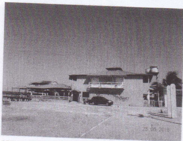
FOTO 03- VISTA GERAL DAS EDIFICAÇÕES DE CONCRETO ARMADO
